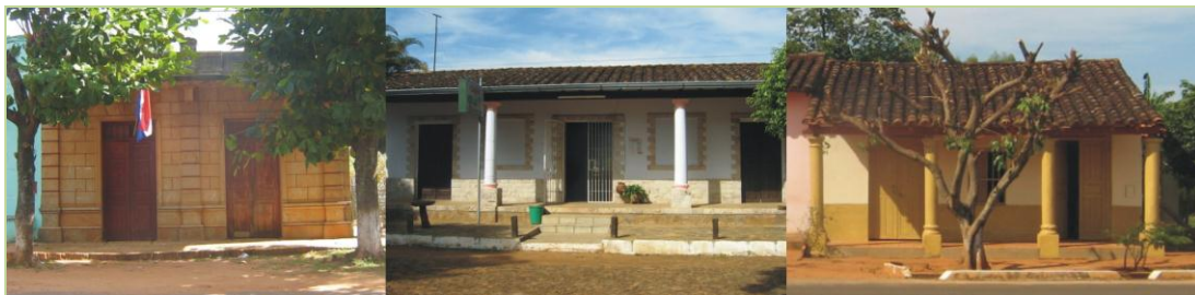
Fotografía nº 8: Edificios patrimoniales de Isla Pucú. Fuente: propia.
