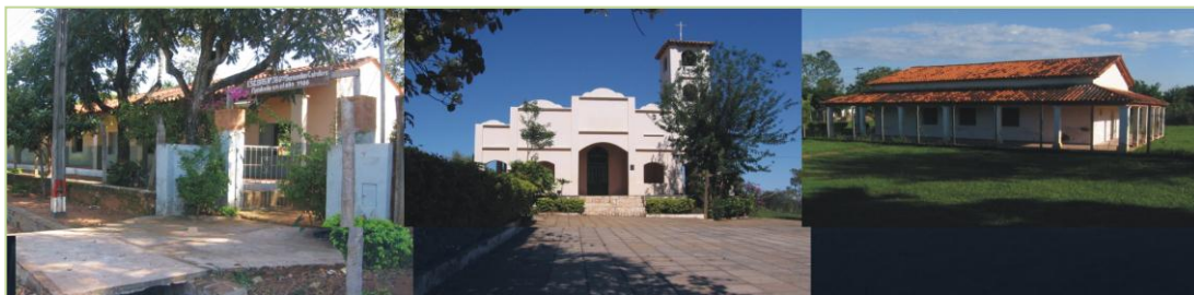
Fotografía nº 9: Edificios patrimoniales de Isla Pucú. Fuente: propia.
