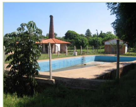
Fotografía n° 20: Piscina Municipal Fuente: propia
