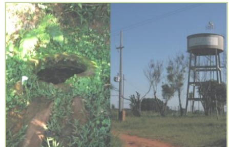
Fotografía nº 19: abastecimiento de agua en Isla Pucú. Fuente: propia
